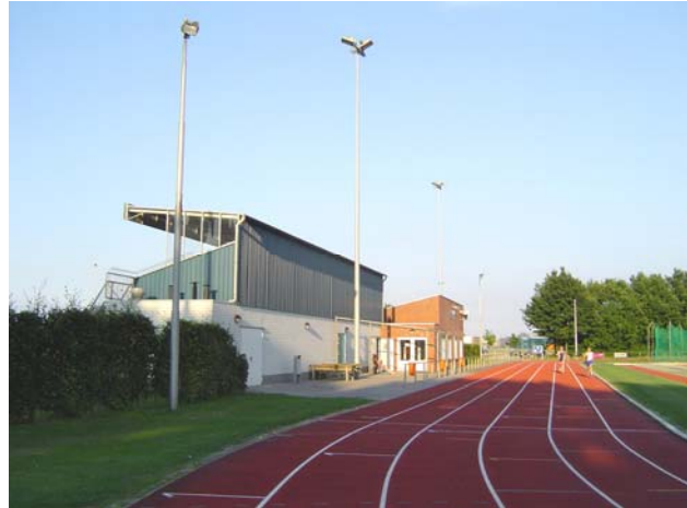
Krachthok, kleedlokalen en Swift @ Home clubgebouw Foto: Peter Willemse
